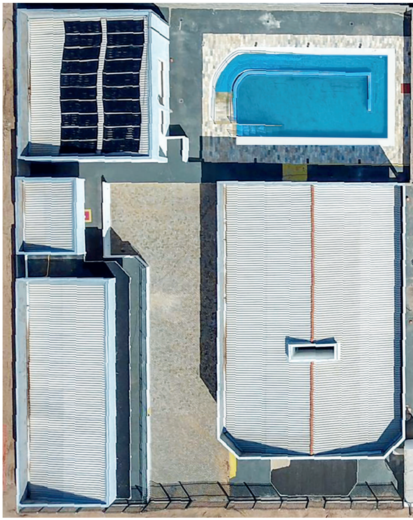
Centro de Saúde Jauru - Obra realizada.
