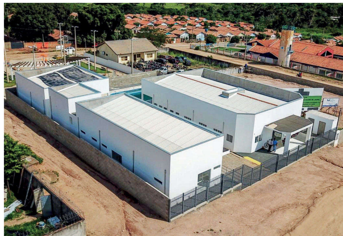
Centro de Saúde Jauru - Obra realizada.
