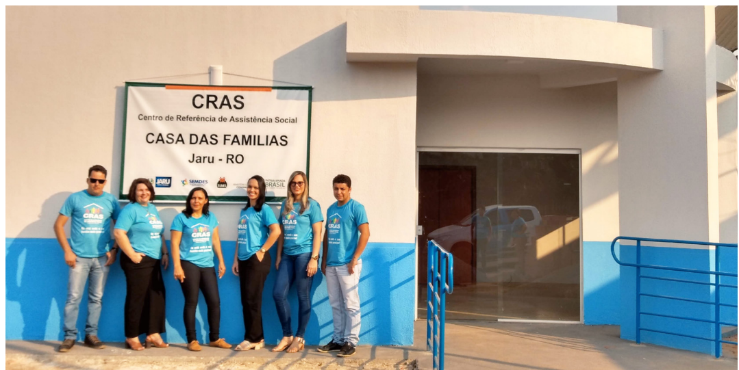
Fachada da nova unidade construída para o CRAS I.
